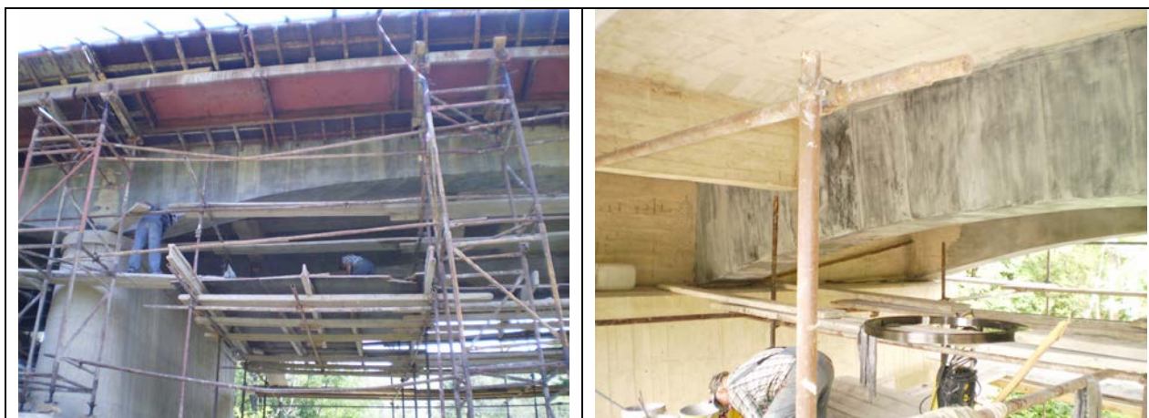
Фиг.6.36 и фиг.6.37 – Снимки от усиление на съоръжението
