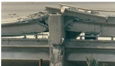
Фиг. 1.5. Разрушен виадукт Cypress Freeway, Loma Prieta 1989 ( https://en.wikipedia.org/wiki/1989_Loma_Prieta_earthquake )
