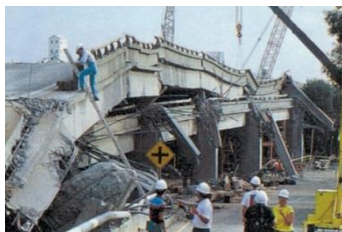
Фиг. 1.5. Разрушен виадукт Cypress Freeway, Loma Prieta 1989 ( https://en.wikipedia.org/wiki/1989_Loma_Prieta_earthquake )
