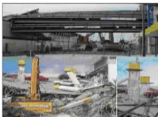
Фиг.1.4. Разрушени сгради вследствие продънване на плочата, Christchurch, 2011 г. ( www.onlinejet.net DOI:10.4103/0976-8580.149487)
